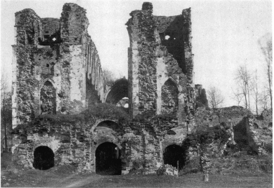
Fig. 6 : Façade de l'abbatiale de Villers avant 1876 : le frontispice de Dewez a entièrement disparu découvrant les contreforts arasés et les fenêtres bouchées. Les plages d'enduit clair perceptibles aux deux niveaux intermédiaires et s'interrompant à l'emplacement des contreforts, appartiennent à une réfection du bâtiment intervenue au début du XVIII<sup>e</sup> siècle (*Copyright* ACL, n° 103955 A).
