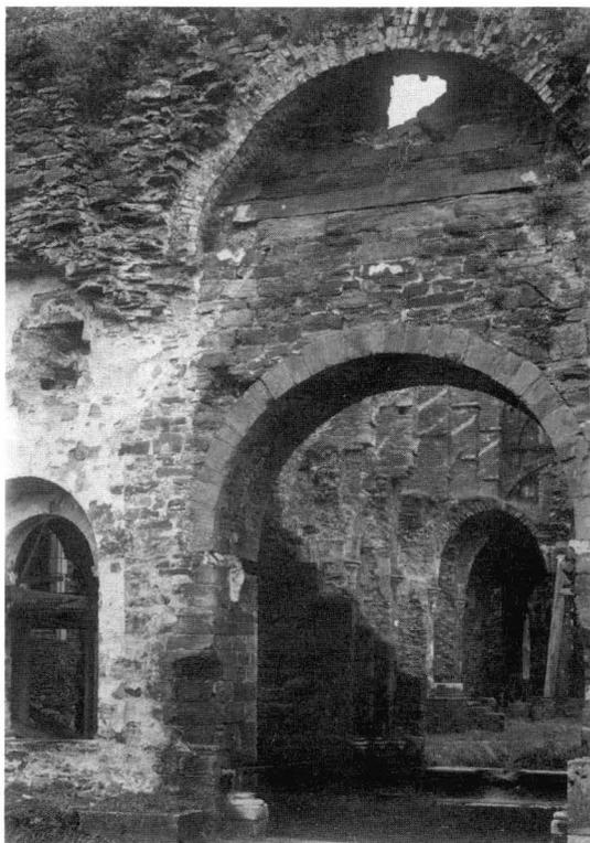
Fig. 7: Portail central de l'avant-corps de l'abbatiale de Villers, vers 1894, pendant le premier chantier de restauration des ruines. L'arc de décharge en brique est encore perceptible au-dessus du glacis de la fenêtre. La petite baie à gauche du portail est fraîchement dégagée (Copyright ACL, n° 103712 A).
