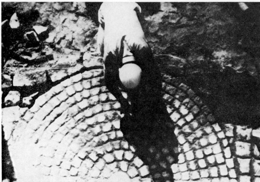
Fig. 4. Les J.P.A. excellent dans la pose de trottoirs en pavés de grès, comme ici, le long des écuries de l'ancienne abbaye d'Heylisseem Phot. V.G.M., 1982.
